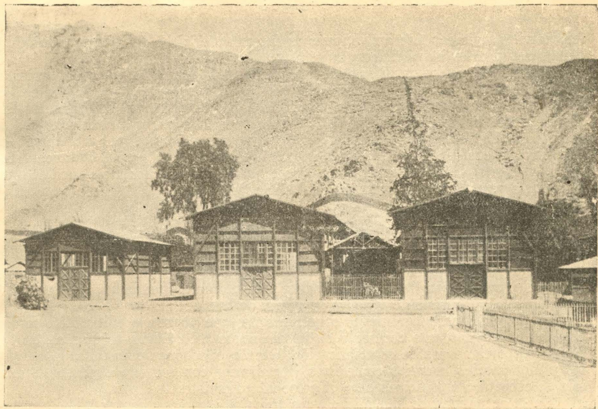
Central Eléctrica, Taller de Mecánica y Taller de Fundición.—Al fondo el cerro en que se encuentra la mina de experimentación
